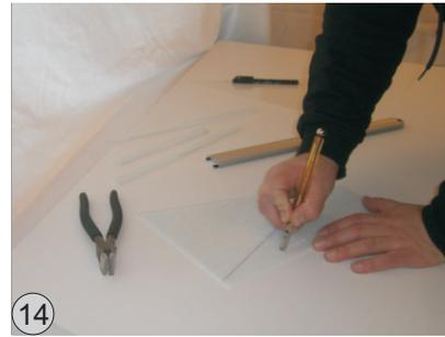
Hier macht es Sinn, erst mit einem groben Schnitt etwas Material abzuschneiden, bevor Sie das Glasstück genau zuschneiden.
